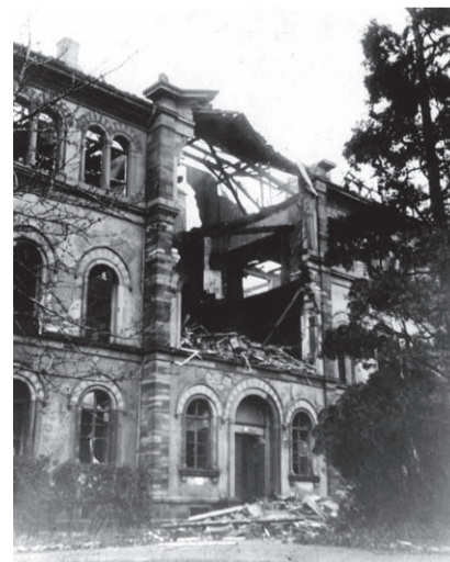
Das Anatomische Institut an der Albertstraße brannte nach dem Bombenangriff im April 1917 gänzlich aus.
