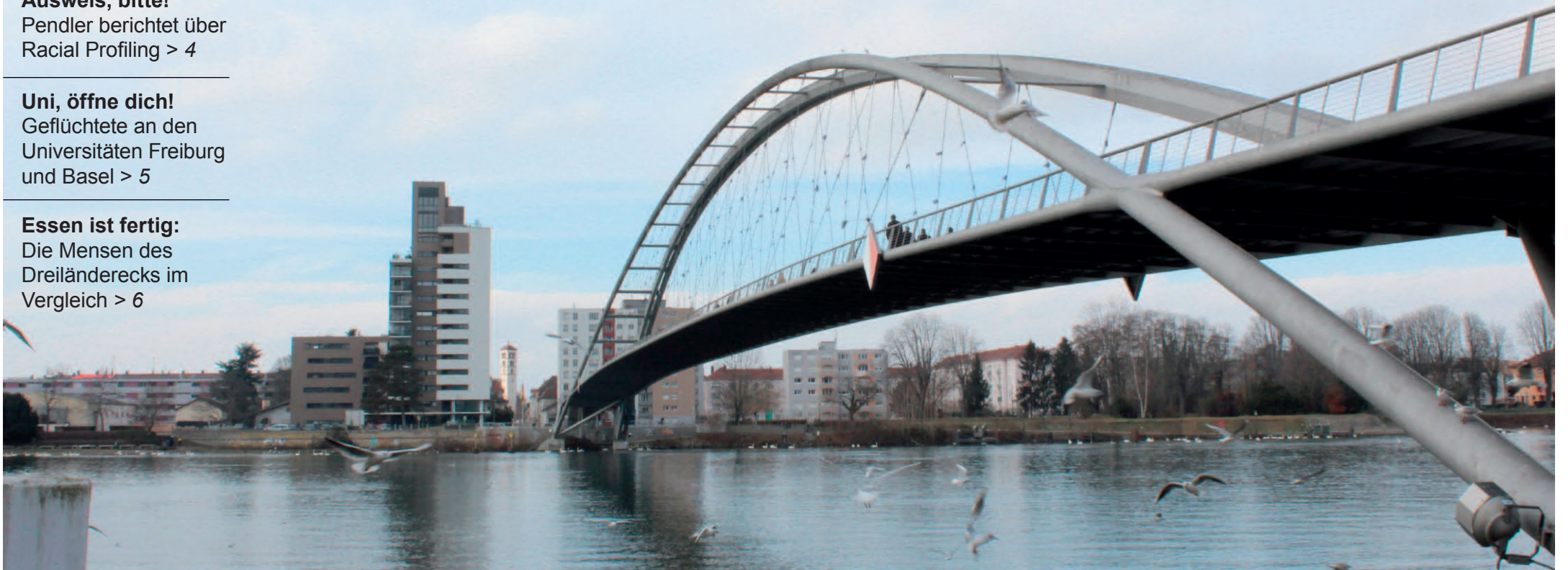
Die Dreiländerbrücke in Weil am Rhein verbindet die drei Eucor-Länder Frankreich, Deutschland und die Schweiz. FOTO: PHILINE SAUVAGEOT
